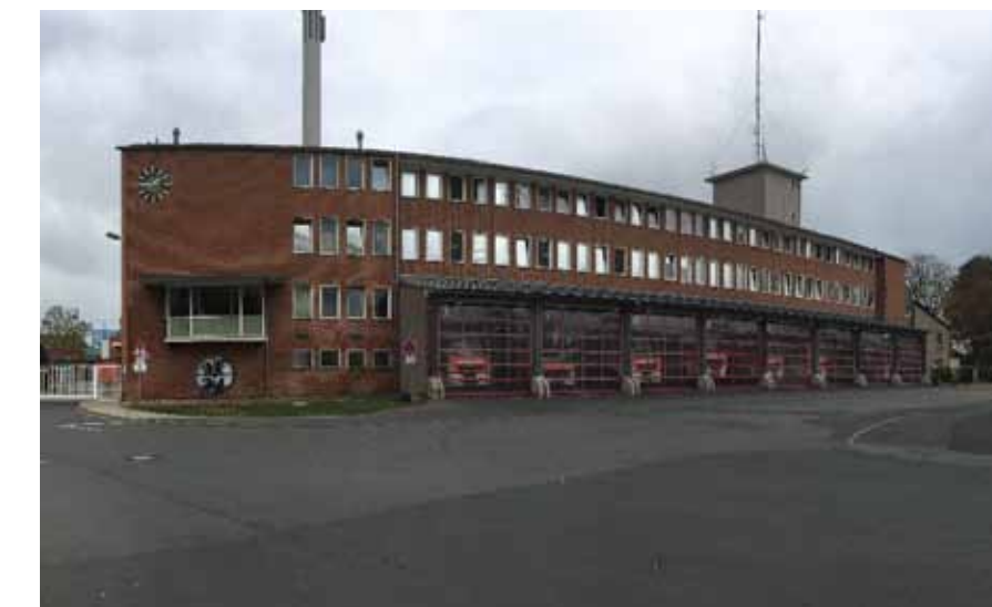
Ansicht der Feuerwache mit den Toren der Fahrzeughalle
