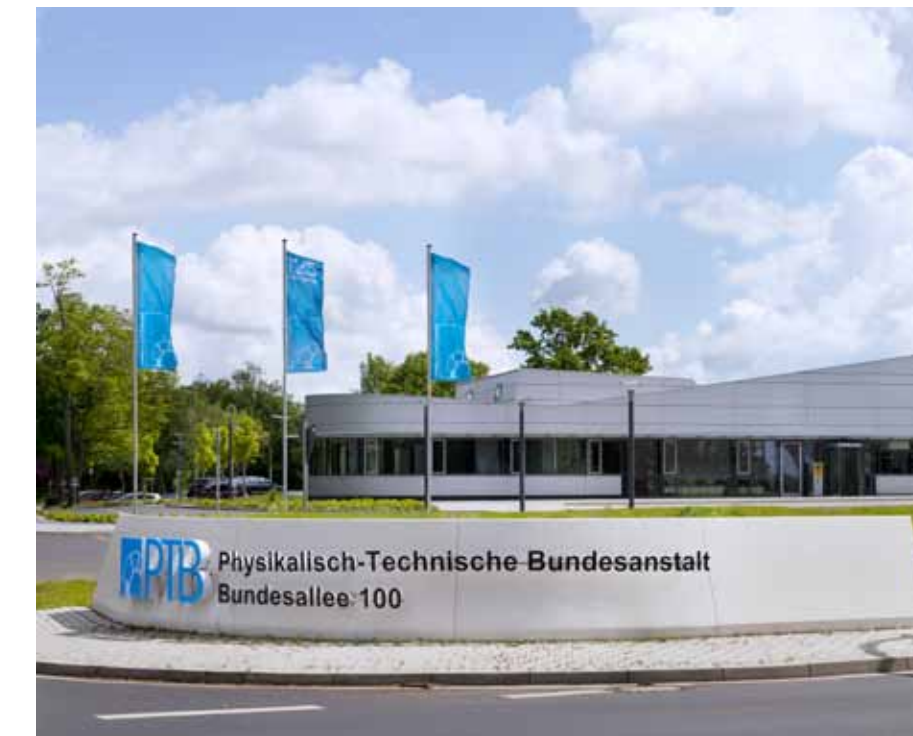
Das Gelände der Physikalisch-Technischen Bundesanstalt (PTB) ist der neue Sitz unserer VDE-Geschäftsstelle.
