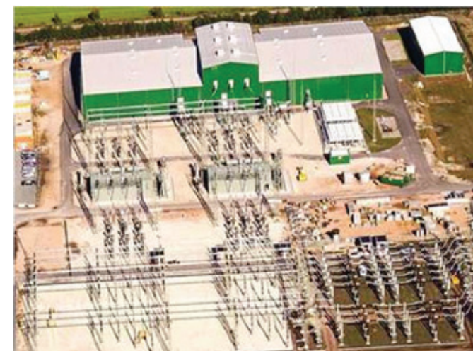
Konvertergebäude von oben
