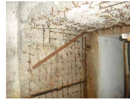
Durchbruch durch die Bunkeraußenwand
