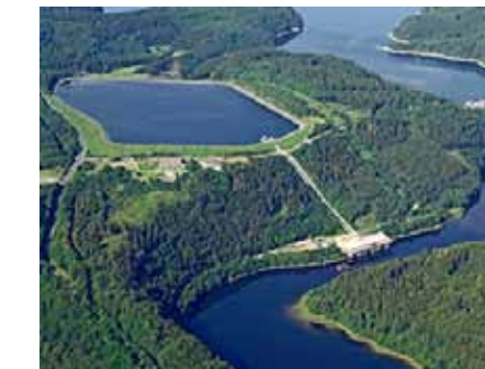
Luftaufnahme des Pumpspeicherkraftwerks.
